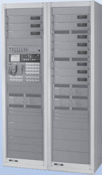
写真は40回線、2,880W(EM-A942D 5台、EM-A922D 6台)の例です。
